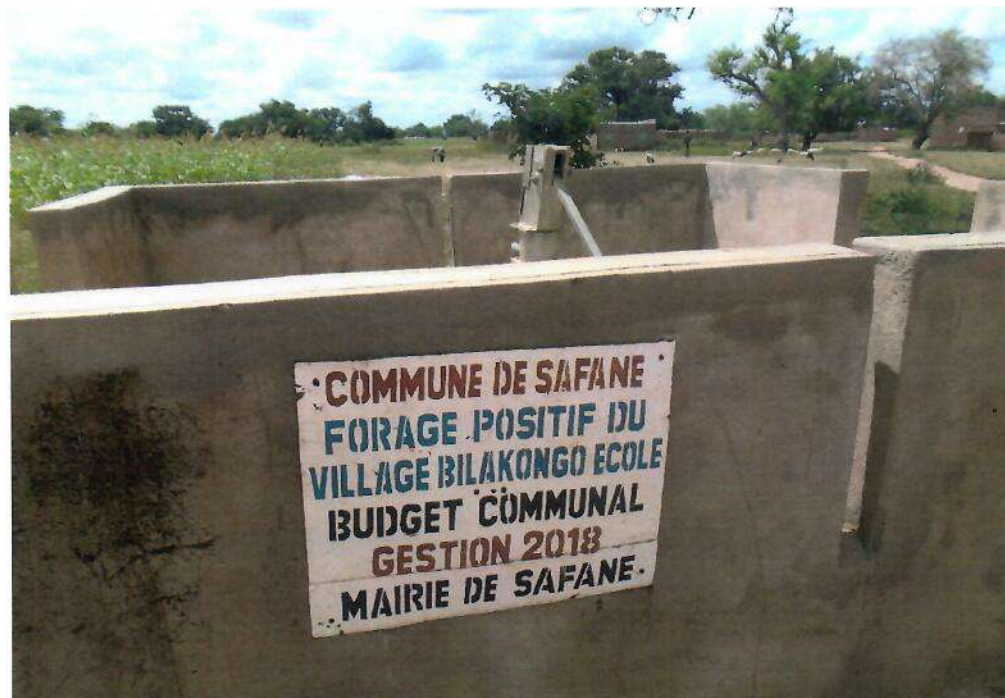
Forage dans le village de Bilakongo réalisé par la mairie de Safané
